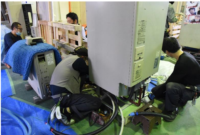
顧客宅に見立てた会場で工事を行う様子
