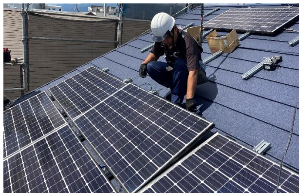
安全第一の工事を行う様子
